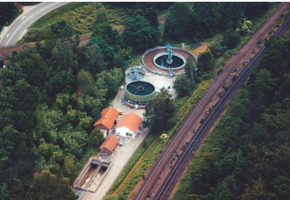
Die Kläranlage in Hochspeyer mit dem zu überwachenden Nachklärbecken.
